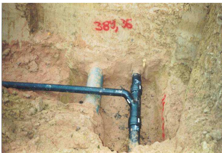
Σχήμα 4: Φωτογραφία ολοκληρωμένης σύνδεσης service line εκ δεξιών
