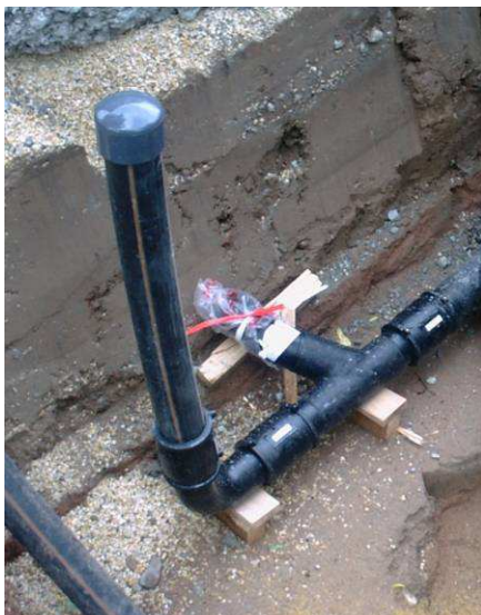
Σχήμα 6: Αγωγός επιθεώρησης HDPE στην αρχή αγωγού
